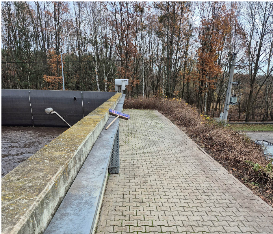
Fot. 4 Zdjęcie korony KTSO – widok od strony budynku stacji odwadniania osadu oraz stacji dmuchaw
