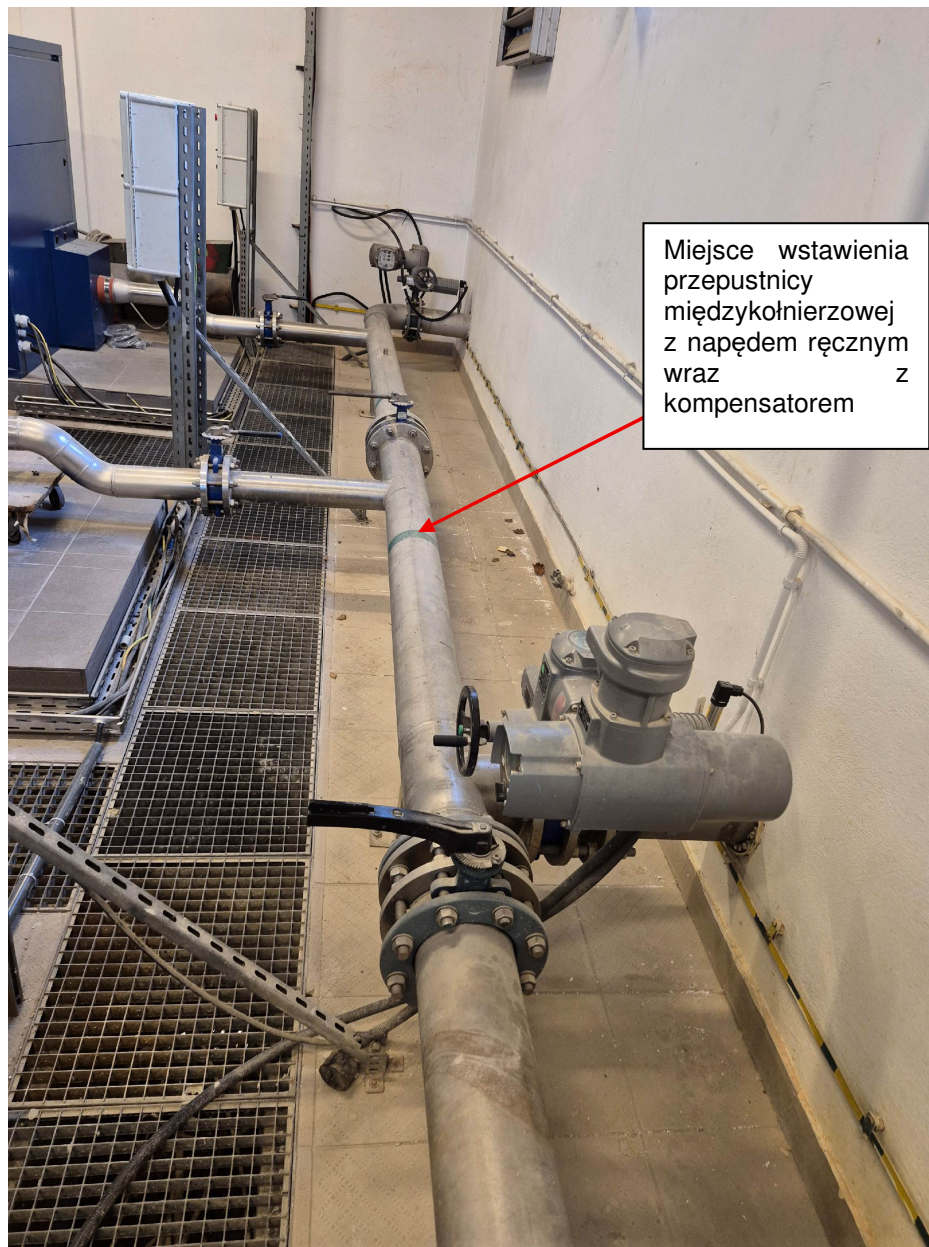
Fot. 5 Lokalizacja montażu przepustnicy międzykołnierzowej
